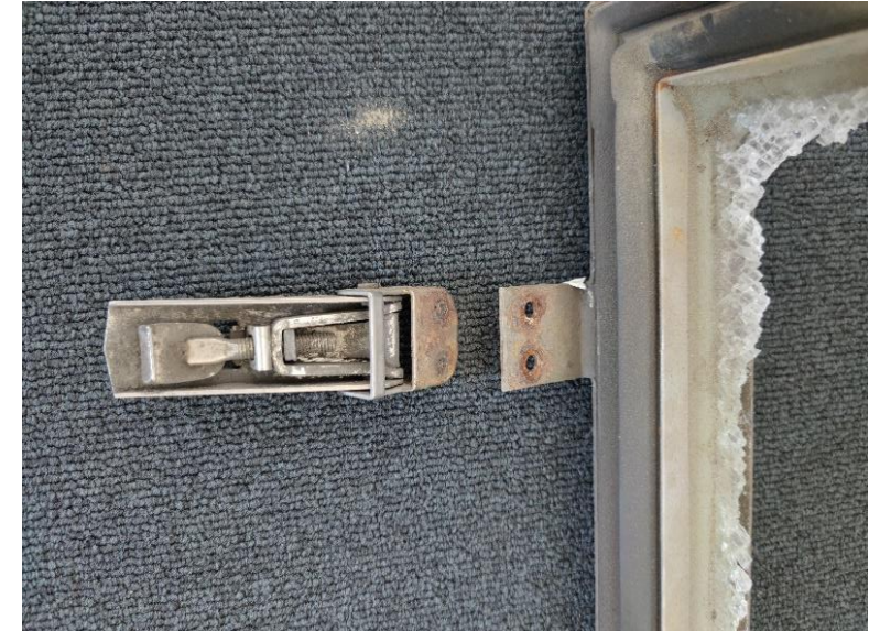
In der Folge unkontrollierte Bauteilabstürze (CRC III)
