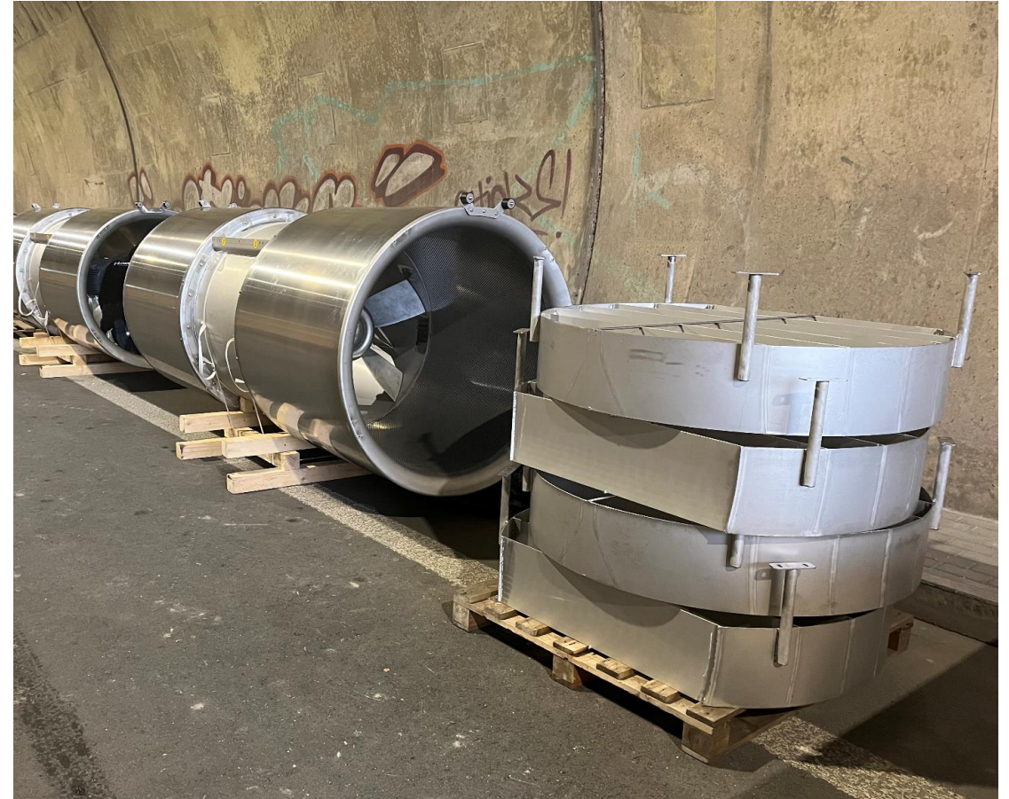
Anlieferung im Tunnel
